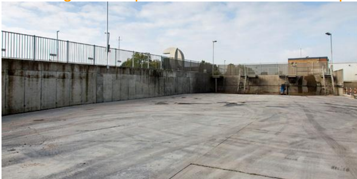
Een opgeruimd terrein is een voorbeeld van Good house keeping.
