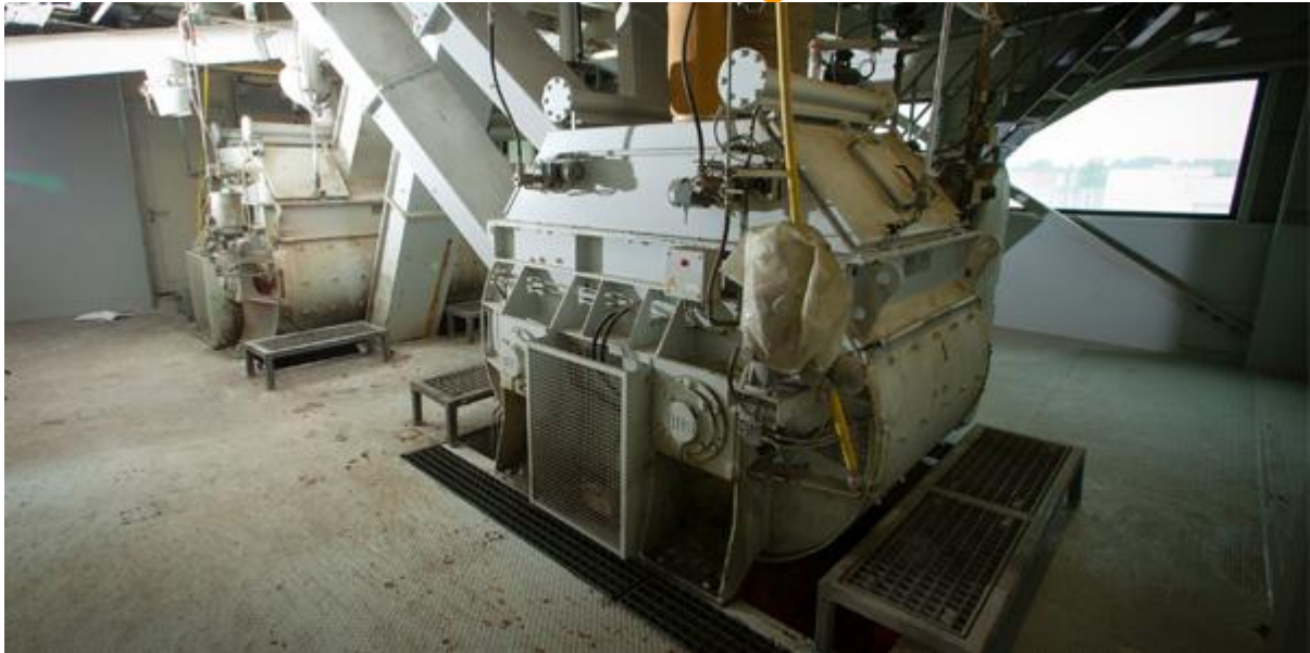
Een menger wordt elektrisch aangedreven en mengt grondstoffen tot betonmortel.
